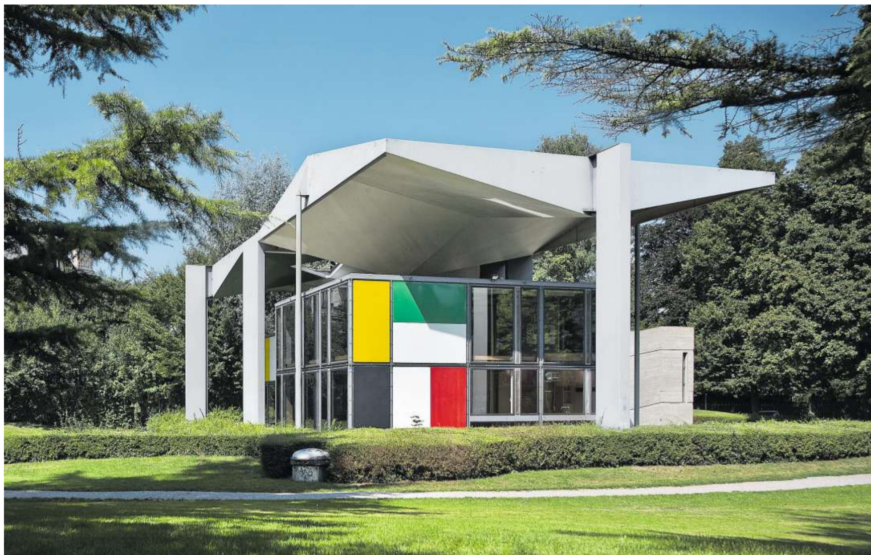
Pavillonarchitektur in der Schweiz 14/36: Mit dem 1967 eröffneten Heidi-Weber-Haus in den Seeuferanlagen beim Zürichhorn schuf Le Corbusier einen der extravagantesten und innovativsten Ausstellungspavillons überhaupt und zugleich eine wegweisende, aber immer noch unterschätzte Ikone der frühen High-Tech-Architektur. ADRIAN BAER / NZZ / © PRO LITTERIS
